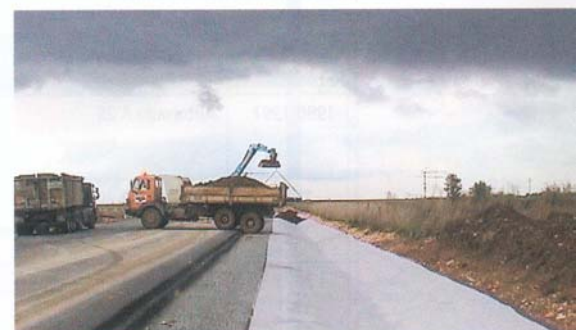
▲ Photos 2 et 3 Mise en œuvre du géocomposite Stabiliner GTX
