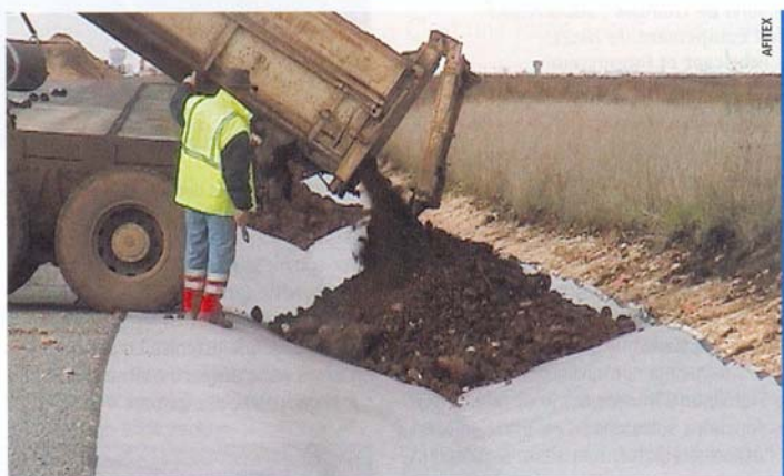
▲ Photos 4 et 5 Mise en œuvre de la terre végétale
