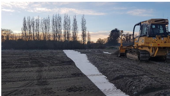
Mise en place du géosynthétique et montage du remblai
