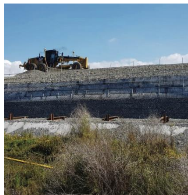
Mise en place du géosynthétique et montage du remblai
