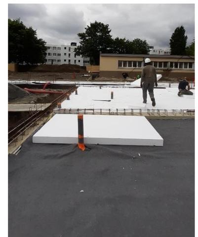
Pose de l'isolation sous dallage sur le ST300
