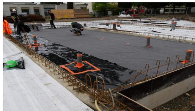
Photo montrant les 3 couches de la solution DRAINTUBE RADON.
