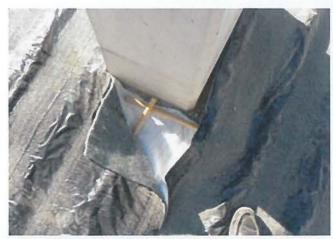
Dans le cas de poteau de faible largeur, en pratique inférieur ou égale à 30 cm, par rapport au sens de l'écoulement dans le SOMTUBE FTB, il suffit de déformer le mini-drain afin de dévier ce dernier le long du poteau, et d'assurer ainsi la continuité de l'écoulement dans le mini-drain.
