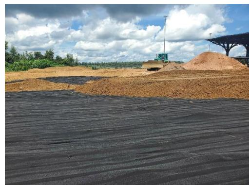
Déroutage du SOMTUBE FTF sur les drains verticaux, et remblaiement
