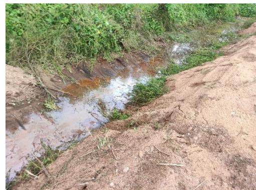
Fin du remblaiement selon les hauteurs de préchargement préconisé et noue collectrice
