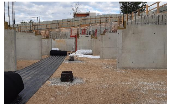
Déroulage sur fond de forme propre et réglé
