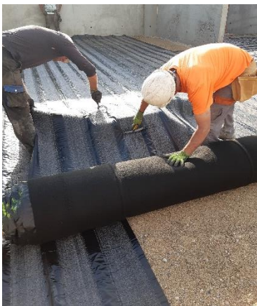
Découpe du SOMTUBE FTB1 autour d'une émergence
