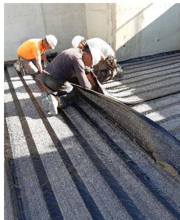
Pelage des lés pour assurer la continuité hydraulique entre deux lés perpendiculaires
