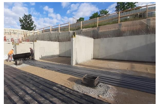
Pose du SOMTUBE FTB1
