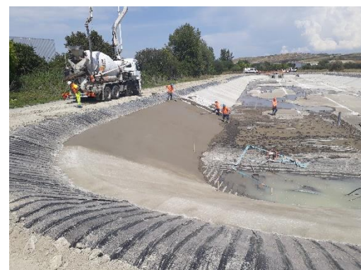
Recouvrements, déploiement dans les talus et tranchées d'ancrages
