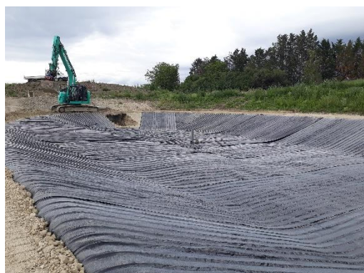
Recouvrements, déploiement dans les talus et tranchées d'ancrages
