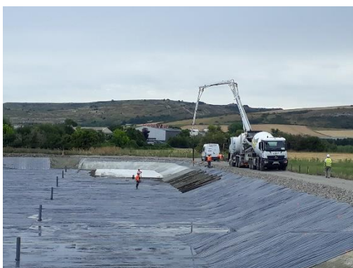
Coulage du béton directement sur le géosynthétique
