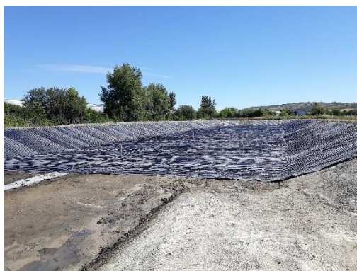
Recouvrements, déploiement dans les talus et tranchées d'ancrages
