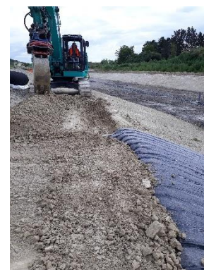
Recouvrements, déploiement dans les talus et tranchées d'ancrages
