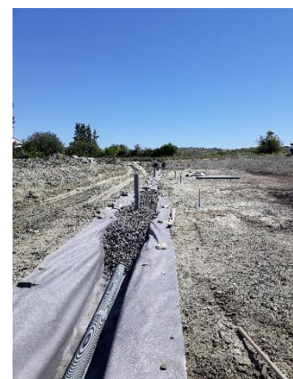
Tranchée collectrice associée à des événements de décompression
