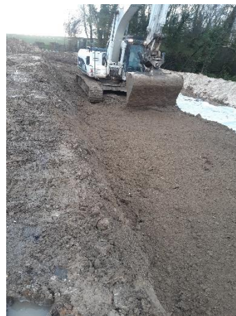
Remblaiement sur les géogrilles et compactage au pied de mouton sur sol fin
