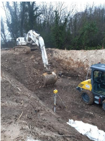
Décassement des talus existant, préparation et mise en place des boudins de géogrille
