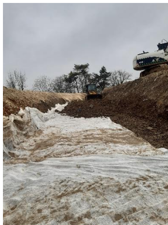
Remblaiement sur les géogrilles et compactage au pied de mouton sur sol fin
