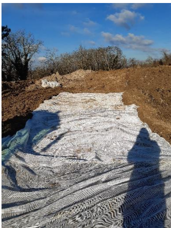
Remblaiement sur les géogrilles et compactage au pied de mouton sur sol fin
