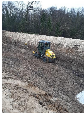
Décassement des talus existant, préparation et mise en place des boudins de géogrille
