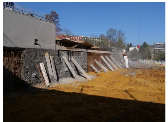
Réalisation des voiles par passes
