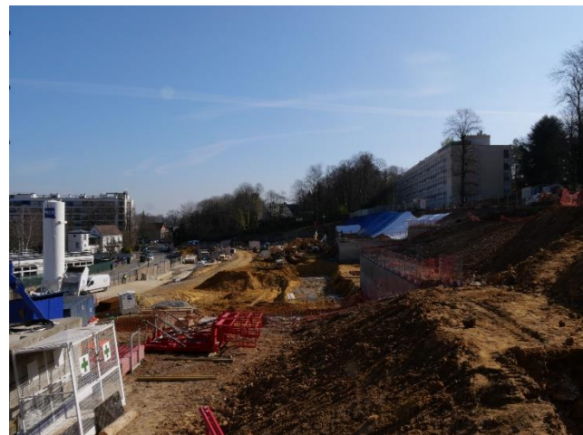
Vue d'ensemble du chantier
