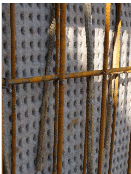
ALVEODRAIN F derrière le ferraillage avant la projection du béton.
