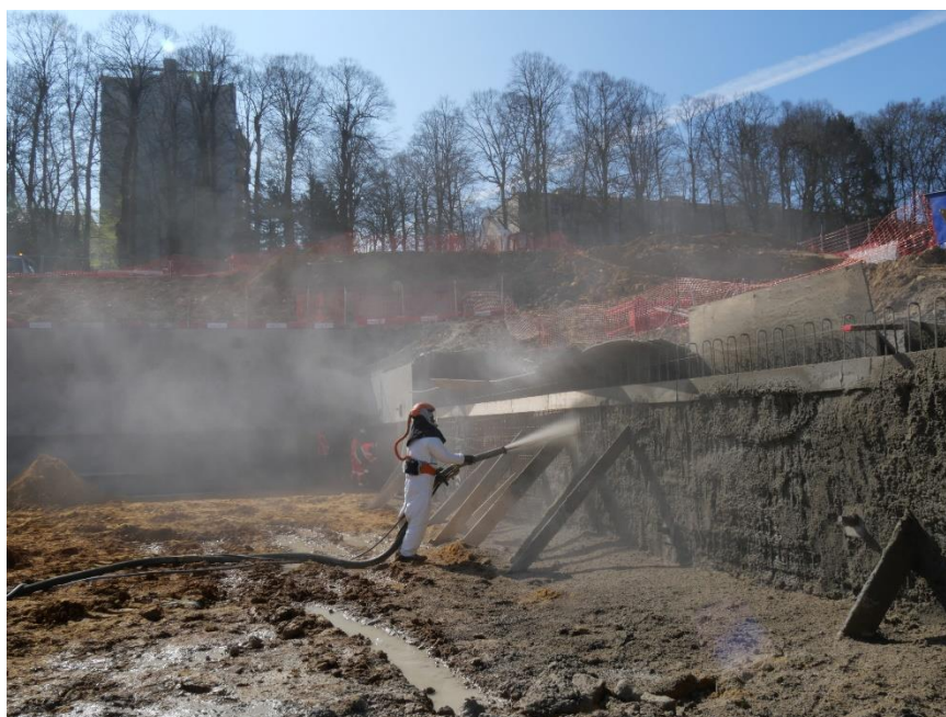
Projection du béton
