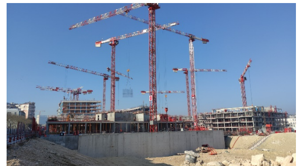
Vision globale du chantier
