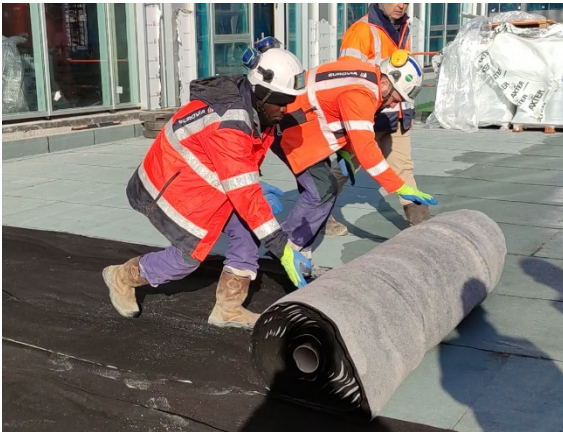
Déroulage du COVERDRAIN FT
