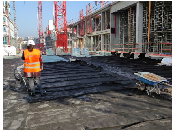
COVERDRAIN FT mis en œuvre
