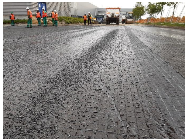
Déroulage, imprégnation par balayage et engravillonnage pour le passage des engins
