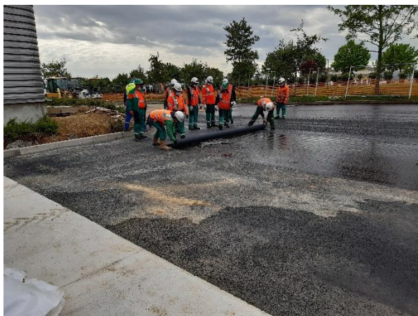
Pose de l'émulsion, mise en place du rouleau et déroulage
