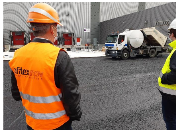
Supervision de la pose sur site par AFITEXINOV
