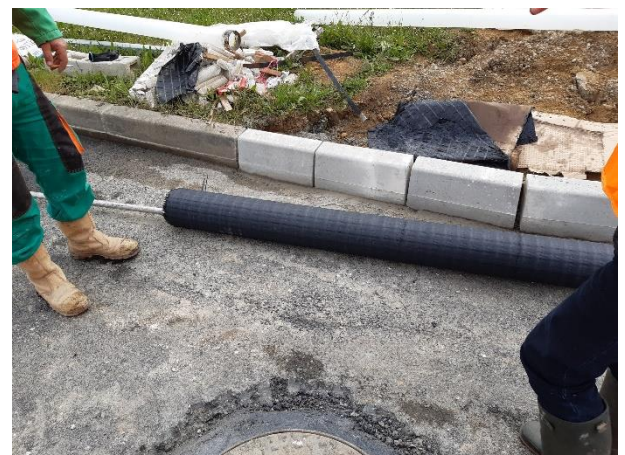
Utilisation d'une barre de levage
