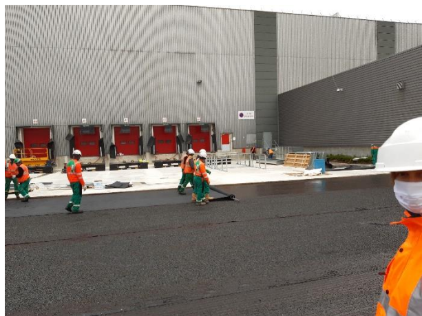
Déroulage, imprégnation par balayage et engravillonnage pour le passage des engins
