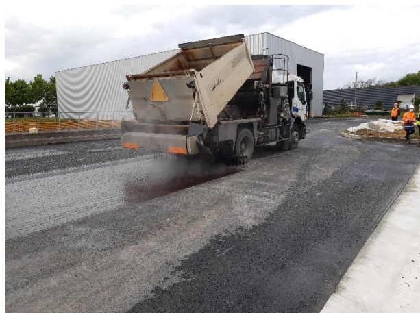
Pose de l'émulsion, mise en place du rouleau et déroulage
