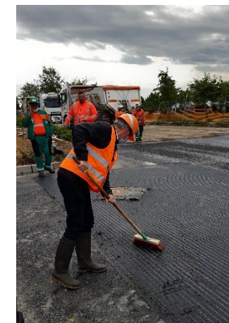
Déroulage, imprégnation par balayage et engravillonnage pour le passage des engins
