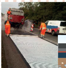
Réhabilitation d'anciennes chaussées prévention de fissurations
