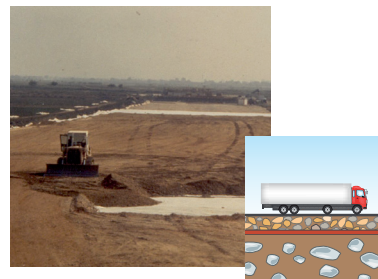
Renforcement de sols peu porteurs : routes, voies ferrées, pistes
