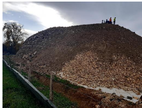
Mise en place du premier lit et remblai finalisé
