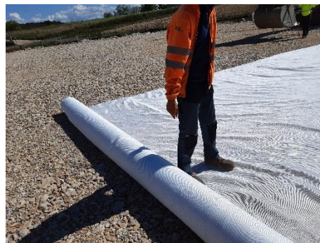
Sol support, déballage et déroulage de la géogrille
